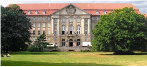
Abb. 17: Kammergerichtsgebäude in Berlin 2
