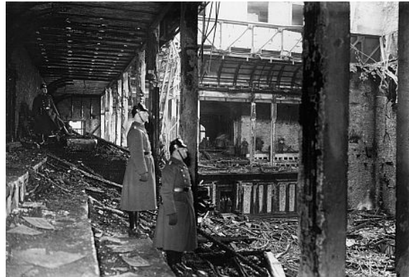
Abb. 6: zerstörter Plenarsaal des Reichstagsgebäudes 2
